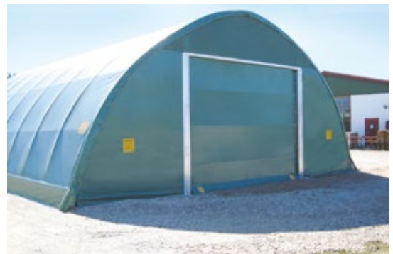
Lagerhalle mit Tor
