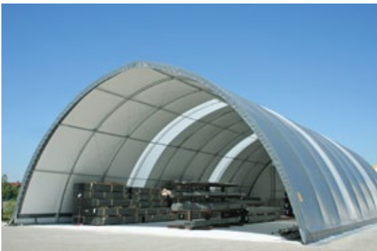
Materiallager Profilträger- Bogenhalle
