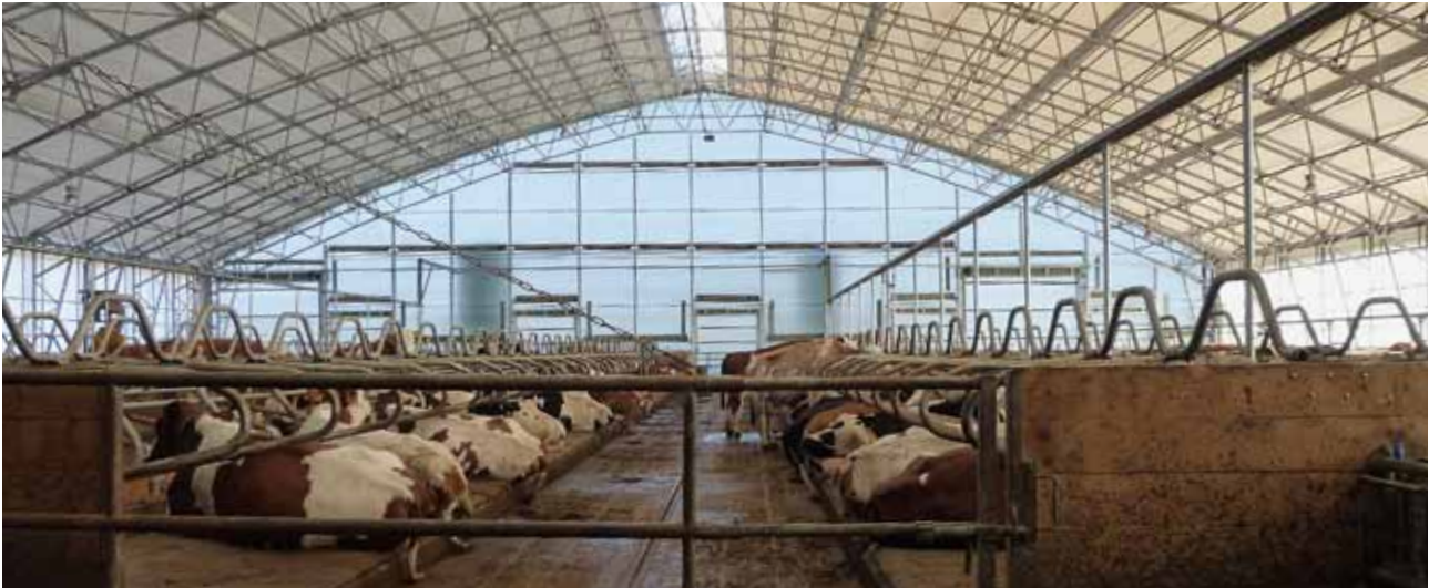
Bild 2: Testbetrieb – Milchviehhaltung (Liegehalle)
