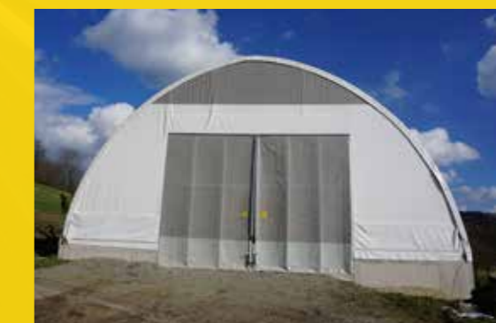
Bogenhalle mit Schiebetor
