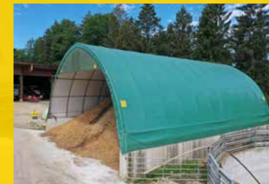
Bogenhalle auf Betonblocksteinen
