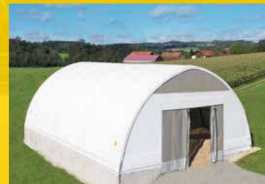
Bogenhalle als Hackschnitzellager
