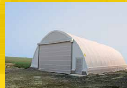
Bogenhalle mit Big-Rippen-Rolltor
