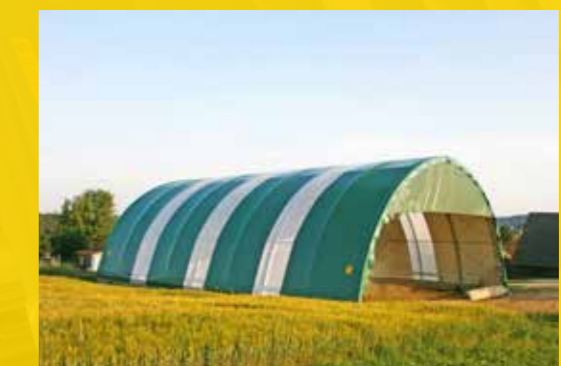
Bogenhalle mit Lichtband
