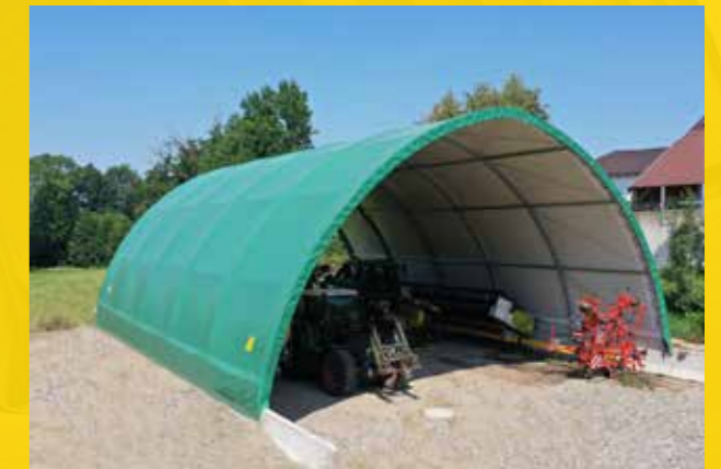
Profilträgerbogenhalle als Maschinenhalle
