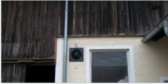
Situación de montaje desde el exterior - ventilador de entrada de aire
