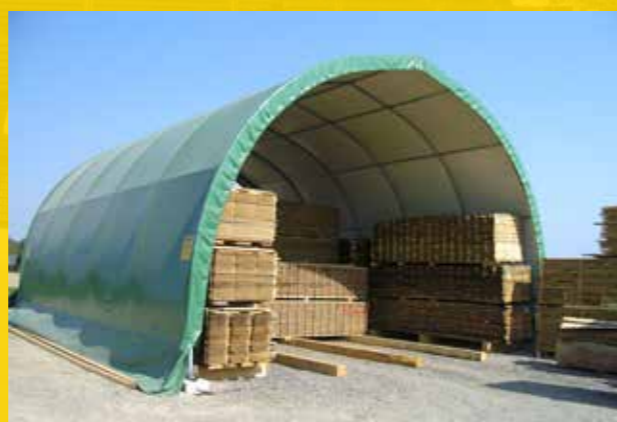
Struttura ad arco a tubi tondi per lo stoccaggio del legno
