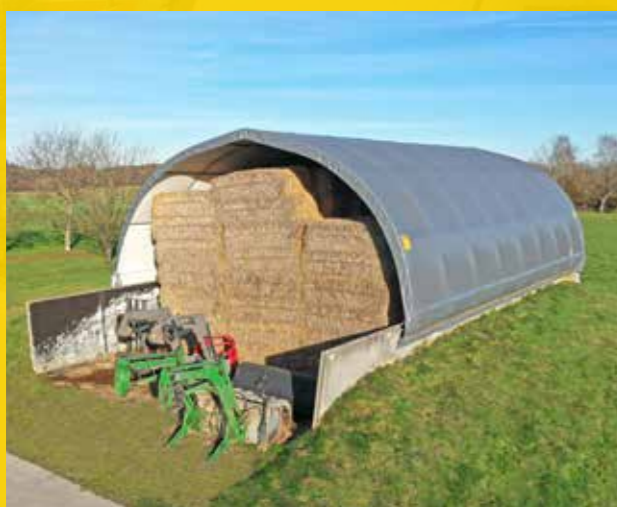
Struttura ad arco a tubi tondi sopra una trincea per lo stoccaggio della paglia
