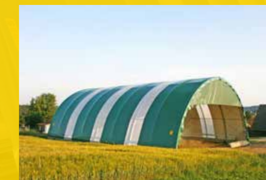
Struttura ad arco con fasce luminose
