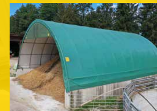
Struttura ad arco su blocchi di cemento, stoccaggio di trucioli di legno
