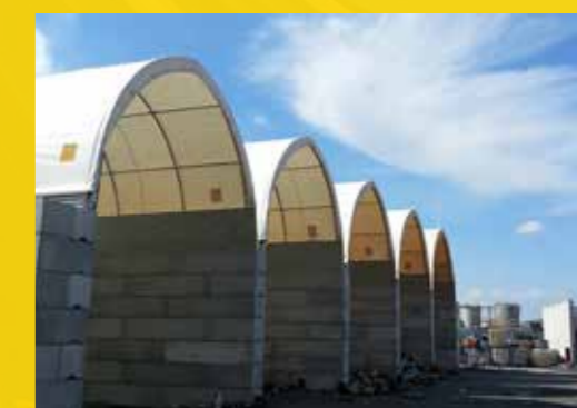
Struttura ad arco, copertura baie di stoccaggio
