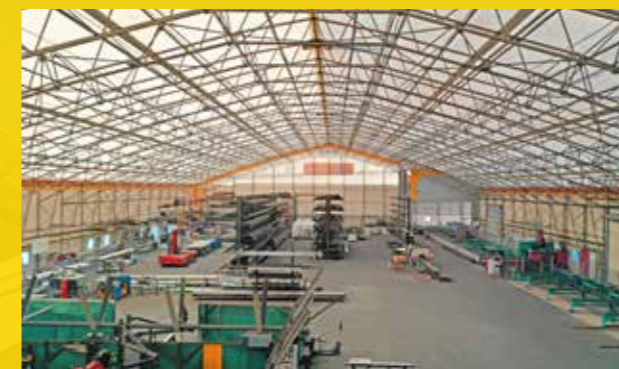
Costruzione in acciaio interna
