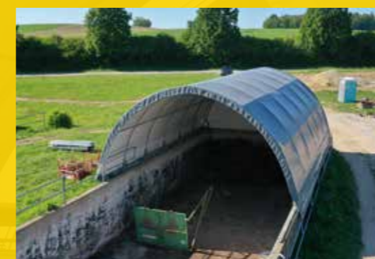
Struttura ad arco su una trincea, Copertura area letame
