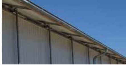
Yağmur suyu oluğu çıkıntısı (1m' e kadar)
