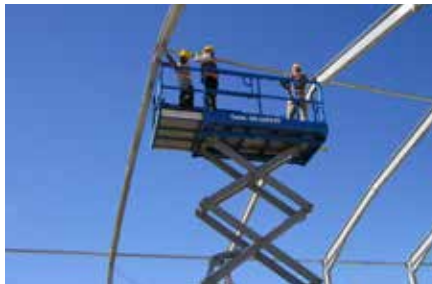
Çelik konstrüksiyonun kurulumu
