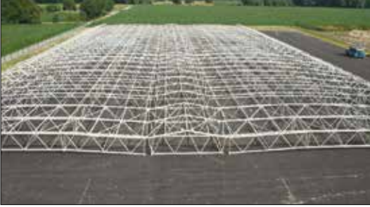
Çelik kafes yapı kirişlerinin montajı
