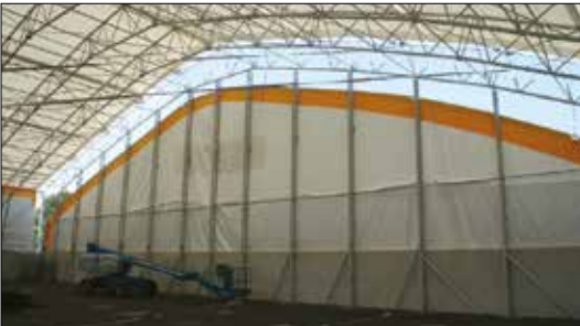
Kalkan duvan membran cephesinin montajı
