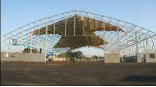
Membran çatı örtüsünün ve membran cephe giydirmesinin montajı
