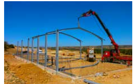
Çelik konstrüksiyonun kurulumu
