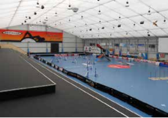
İç membran ile yalıtılmış hokey salonu
