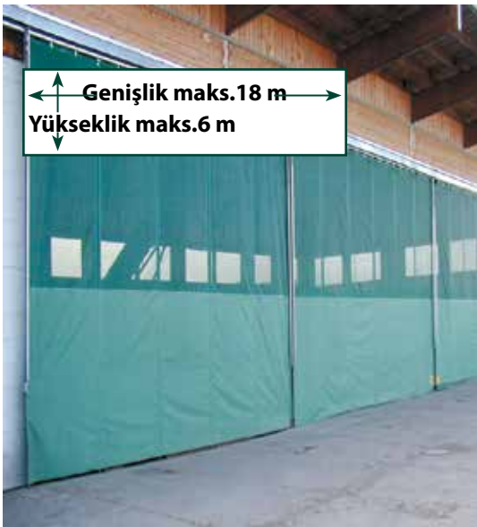
Makine deposu sürgülü kapı
