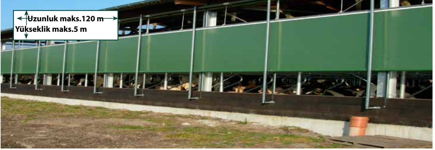
Gölgelik konumundaki yan duvar sarmal sistemi
