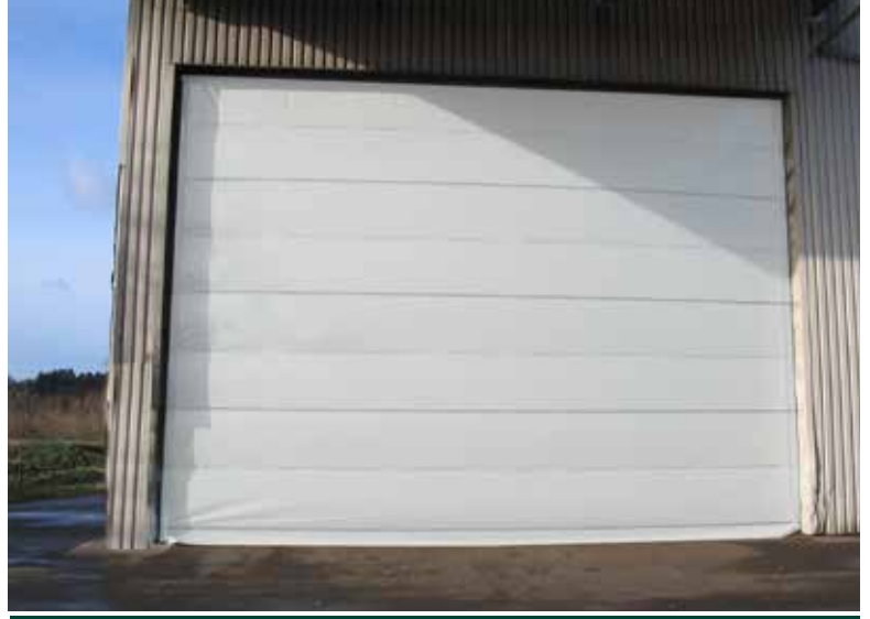
Katlanır kapı genişliği 12 m yüksekliği 8 m
