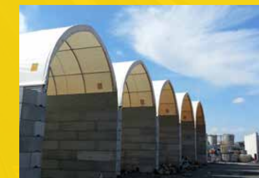
Tunnel sur box
