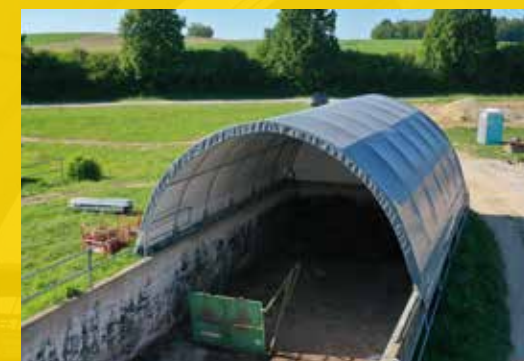
Tunnel sur silo
