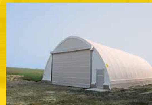
Tunnel avec grande porte à enroulement renforcé
