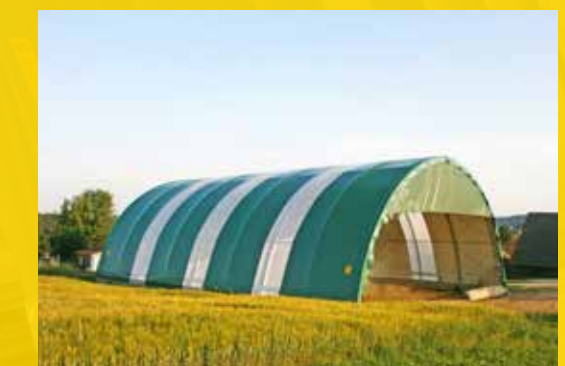
Tunnel avec bande lumineuse
