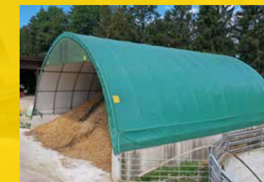
Tunnel sur mur en béton
