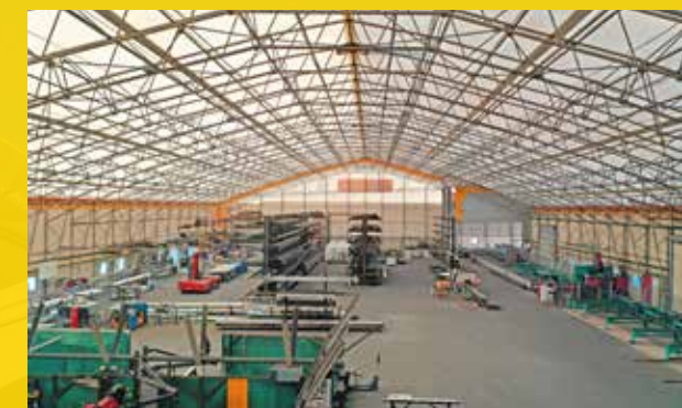
Construction métallique interne
