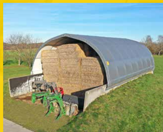
Construction sur silo - stockage de foin
